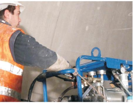
Injektiranje kao mjera sanacije osigurava konstruktivnu cjelovitost, trajnost i punu funkcionalnost građevine (npr. sprečavanje gubitka sadržaja iz cjevovoda, rezervoara ili silosa) a ujedno otklanja mogućnost šteta na instalacijama, opremi i inventaru uzrokovanih prodorima oborinske ili podzemne vode. Prilikom injektiranja koristimo tvornički pripremljene materijale sukladno namjeni:
