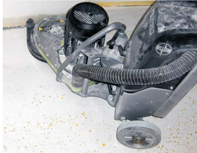
gore: obrada i brušenje poda uz spoj sa zidom
